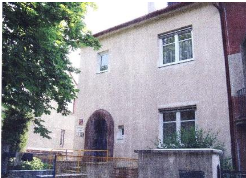
Před rekonstrukcí 2. 7. 2009 (foto: archiv mateřské školy).
