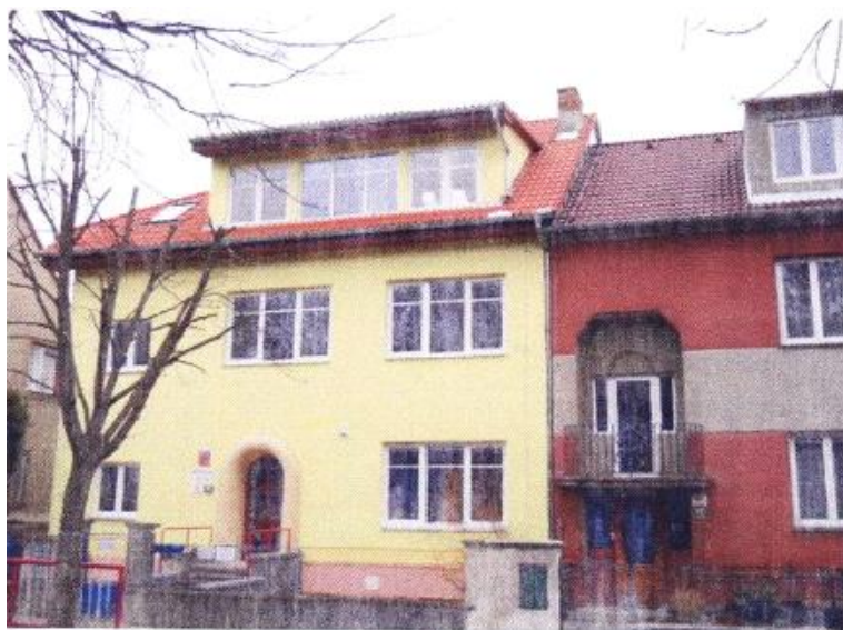
Po rekonstrukci 17. 2. 2011. (foto: archiv mateřské školy)
